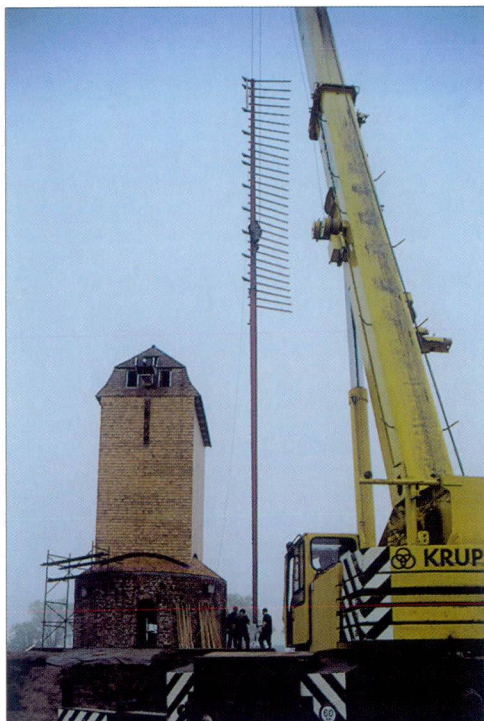
Foto op de kافت: het Fort Napoleon in Oostende. (Foto Daniël de Kievith, Oostende).
