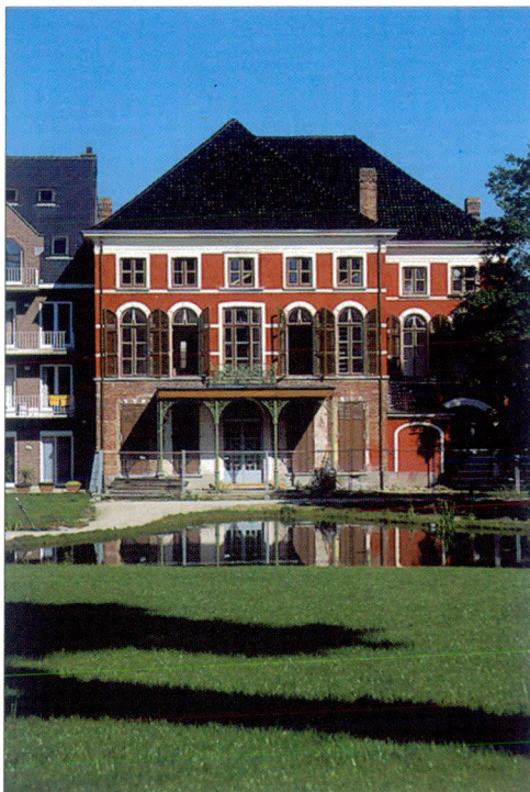
Links: de tuingevel van het herenhuis Mulle de Terschueren vóór de aanvang van de restauratie, begin 1999. (Foto MR).
